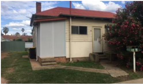
Unit 2, 67 Marquis St, Gunnedah
